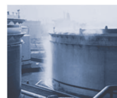
storage groove LNG
